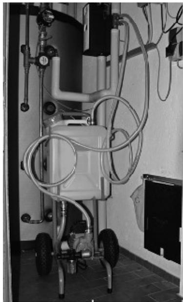
7. Ouvrir le couvercle du réservoir pour assurer la circulation d'air.
